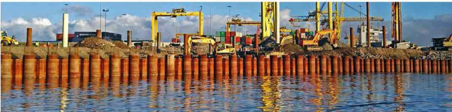
VIGA W (IPR) + TABLESTACA
