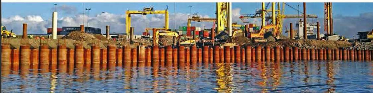
VIGA W (IPR) + TABLESTACA
