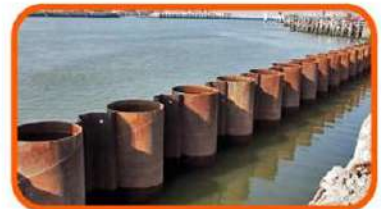
Muros Combinados Combi Wall p. 10
